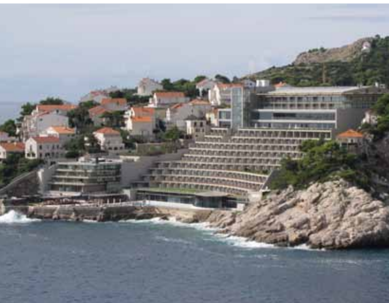
Kongreshotellet. Etage-nummereringen var negativ, eftersom indgangen i toppen fra landsiden. Kongressen foregik højt oppe, på etage -1.
