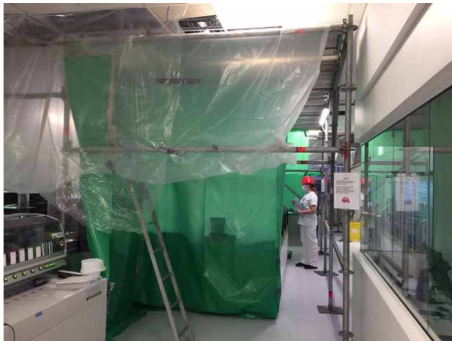
Figur 2 Der arbejdes under stillads i forbindelse med udbedring af airconditionanlæg.
